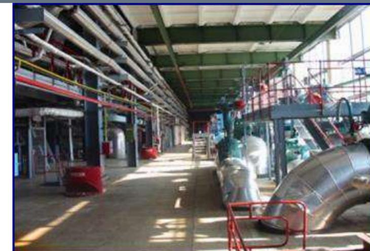
Котельный цех – **14 энергетических котлов** в главном корпусе, **9 котлов ТГМ-84** паропроизводительностью по 420 т/ч и **5 котлов ТГМЕ-464** паропроизводительностью по 500 т/ч производства Таганрогского завода «Красный котельщик».
